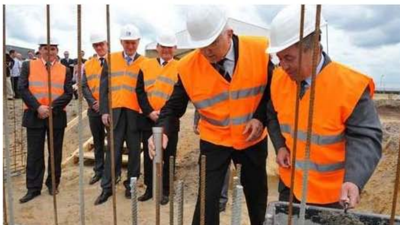
Tuby zostały przykryte betonem, dzięki czemu na zawsze pozostaną w fundamentach zakładu (fot. Tomasz Gawalkiewicz)
